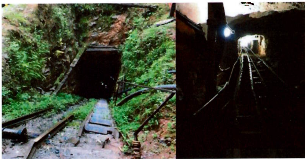
Figura 8 - Túnel de acesso à galeria principal
